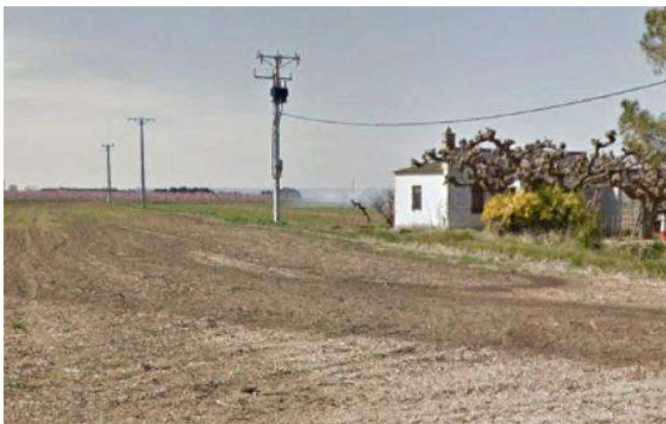
Figura 12: Possibles torre elèctriques de connexió per la ubicació 4 a Els Alamús
