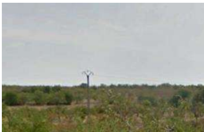
Figura 24: Possibles torre elèctriques de connexió per la ubicació 9 a Arbeca
